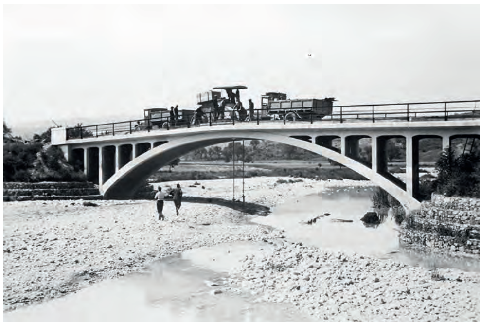
Fig. 17. Le opere di bonifica della Val d'Orcia
