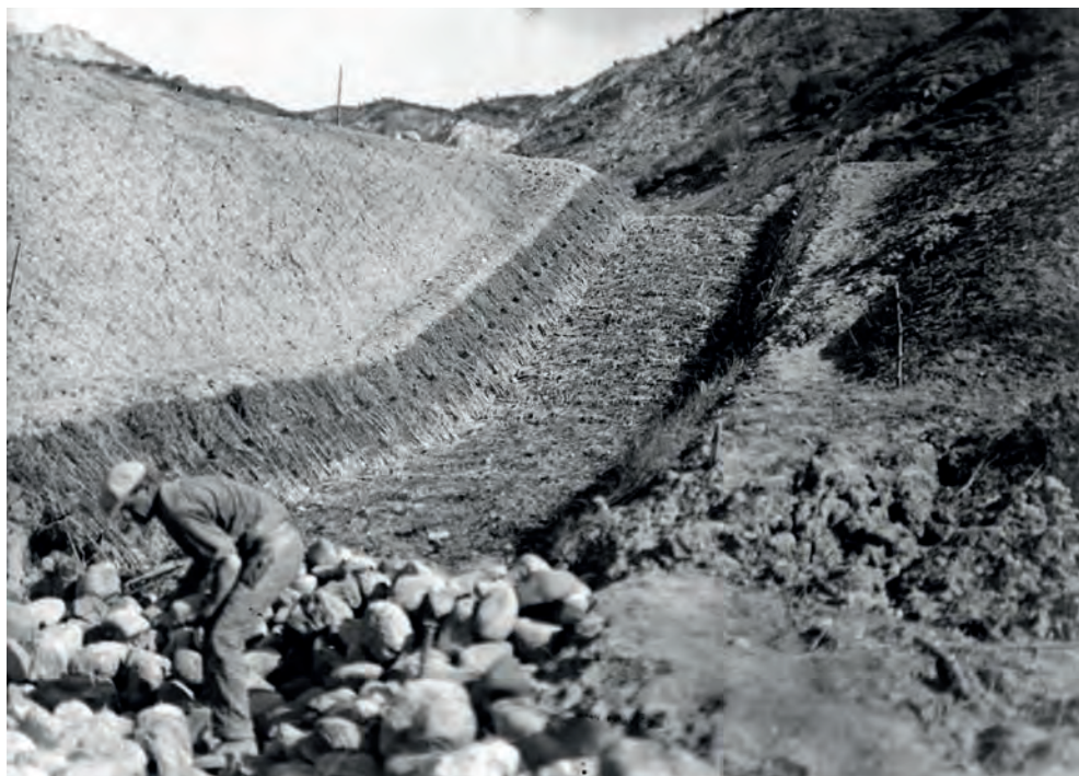
Fig. 4. Lavori di bonifica del suolo
