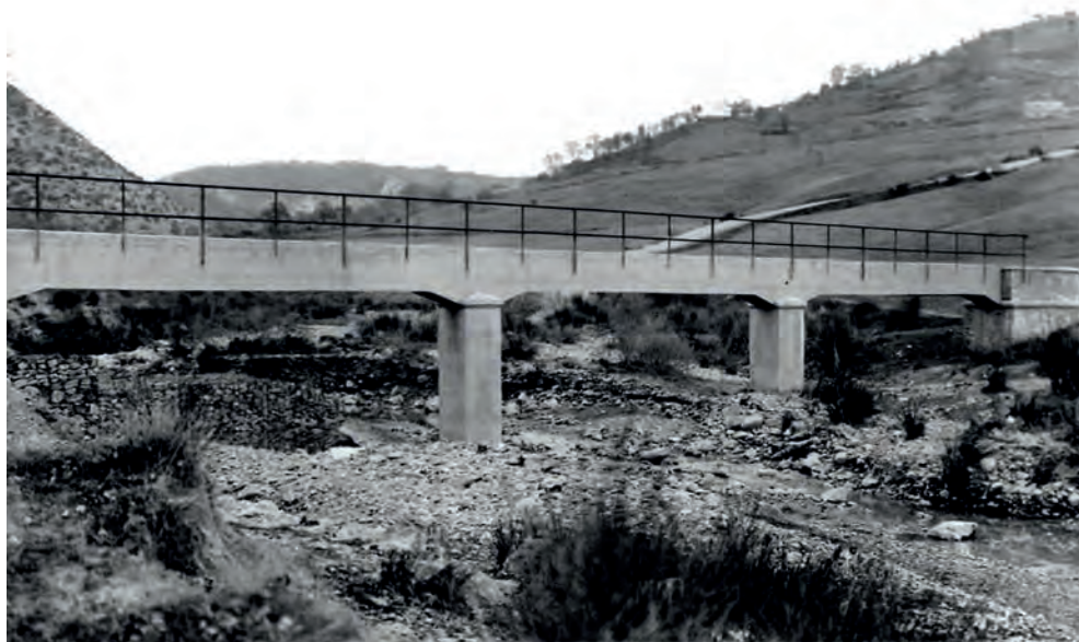
Fig. 5. Ricostruzione di un ponte
