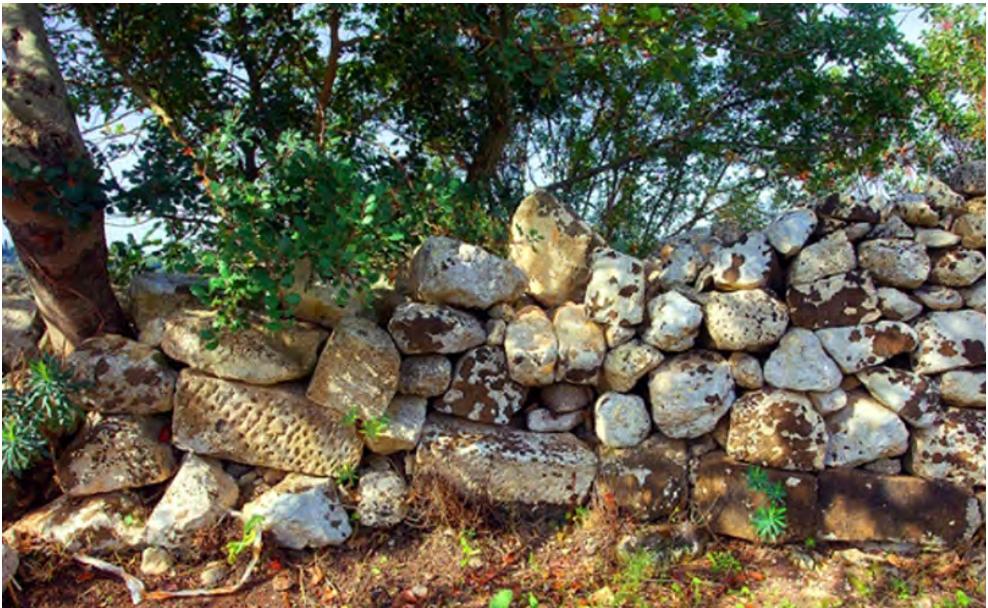
Fig. 6. Castel di Lega di Ferla: muro a secco con conci squadrati di riempiego (foto di D. Barucco)
