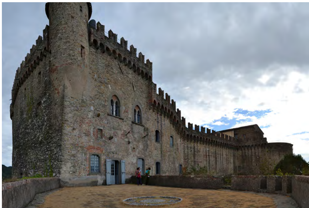
Fig. 14. Vista dal bastione dell'orologio
