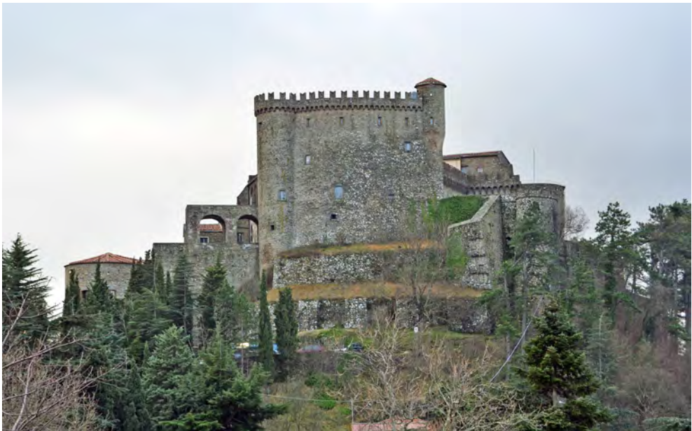
Fig. 2. Castello di Fosdinovo. Vista del prospetto volto a settentrione
